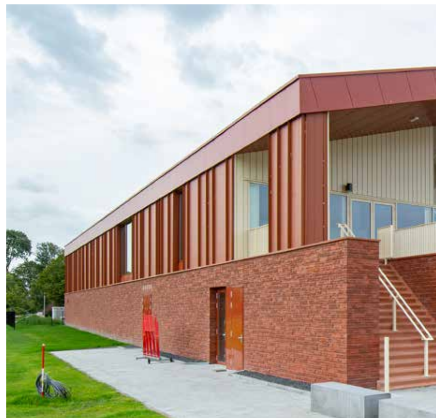
Het casco voor het zwembad werd opgebouwd uit prefab beton. Voor de opbouw werd gekozen voor een staalconstructie met sandwichpanelen en het dak werd opgetrokken in staalplaat.
