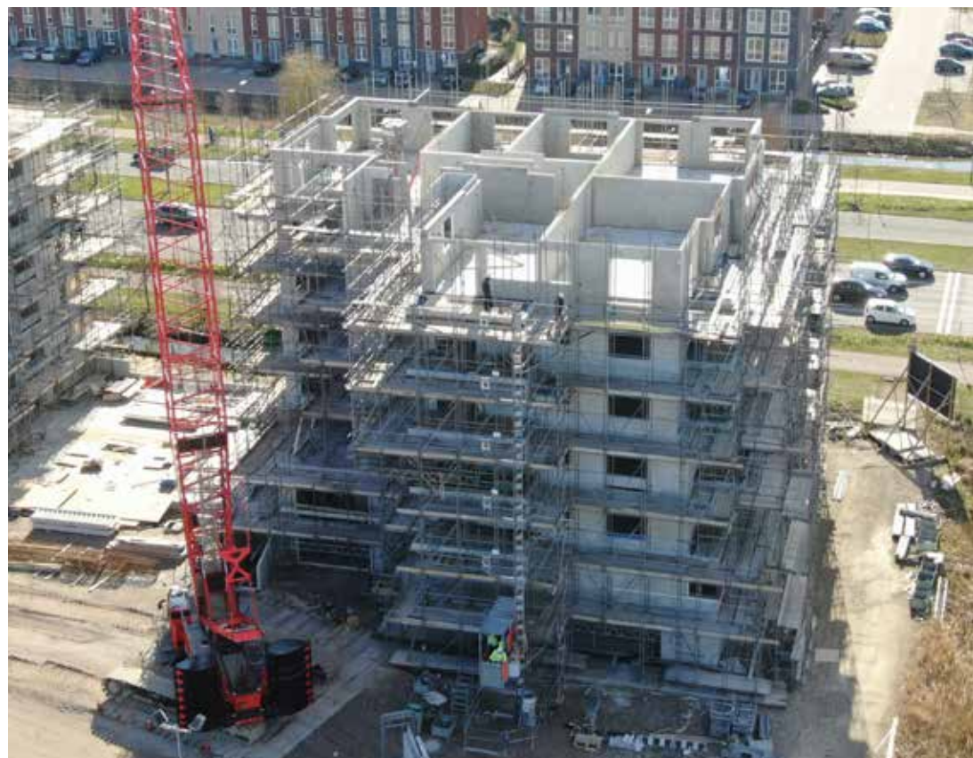
MBS Cascobouw past bij dit project ook de laatste technieken toe om de breedplaatvloeren veilig te monteren.
