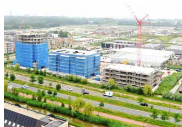
Van links naar rechts: Koningslinde, Zilverlinde en Witte Linde. In totaal levert MBS Cascobouw voor het project de Linden circa 1.100 prefab elementen.
